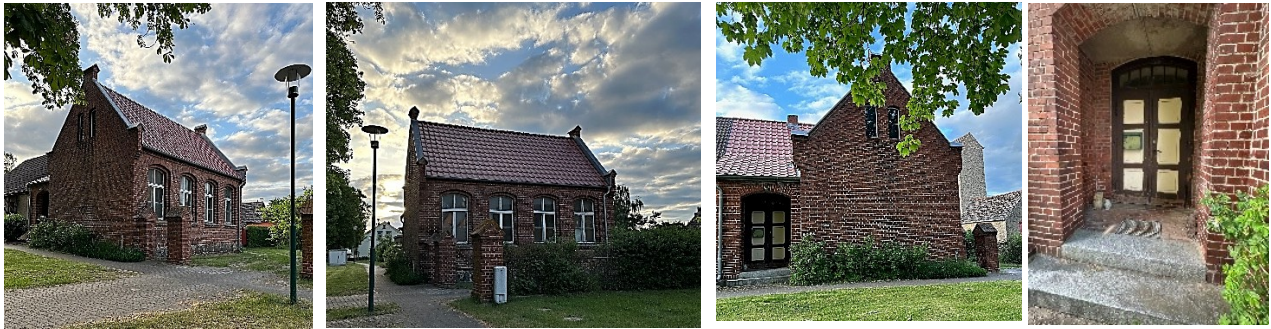
Die Schule von Seebeck – eines der wenigen Gebäude in Seebeck, das unter Denkmalschutz steht
